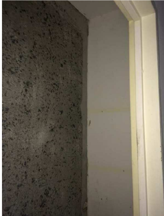
Enduit de débullage en fond de placard :
