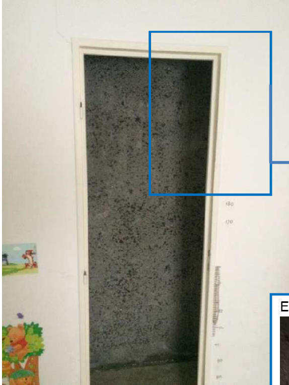
Enduit de débullage en fond de placard :
