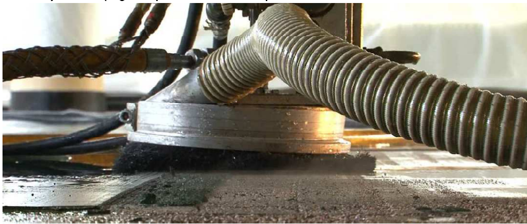
Tête d'hydrodécapage en pleine action de dépose :
