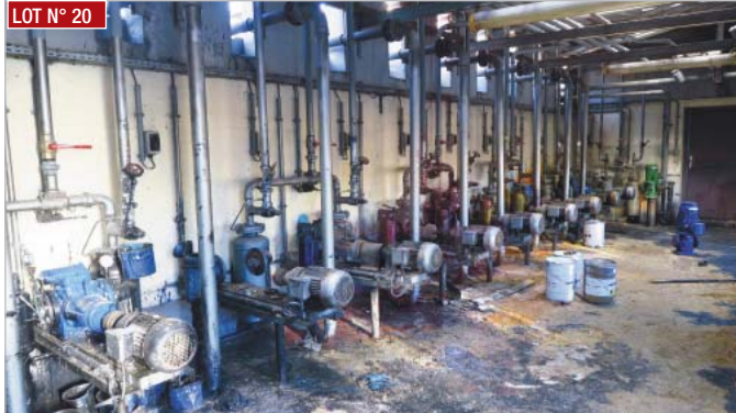
► Poste de distribution pour les encres comprenant 5 pompes ROTAN et 5 pompes de dépotage colorant ► Dispensing station for inks comprising 5 ROTAN pumps and 5 colouring agent transfer pumps
