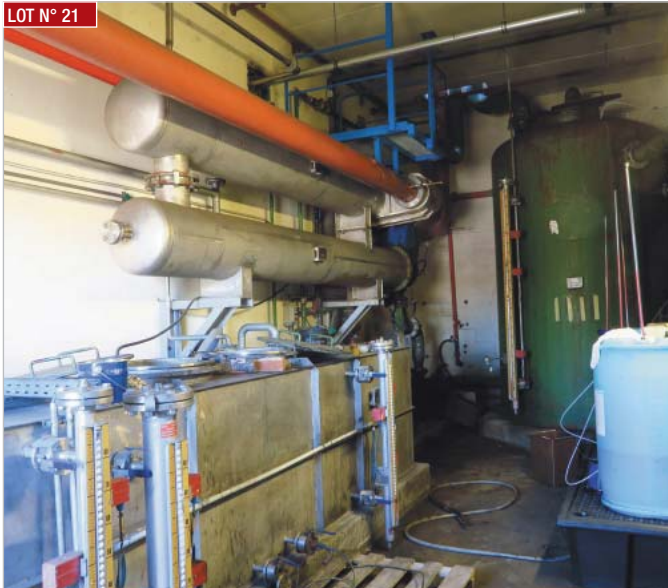
► Poste de récupération des solvants LURGI (1995): process utilisant le charbon actif ► LURGI solvent recovery station (1995) employing a process using activated carbon
