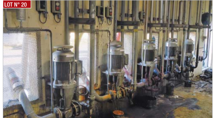
► Poste de distribution pour les encres comprenant 5 pompes ROTAN et 5 pompes de dépotage colorant ► Dispensing station for inks comprising 5 ROTAN pumps and 5 colouring agent transfer pumps
