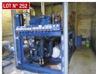
▶ Groupe froid SODIFRI , type CCE 6SHB 60Y (2005), pds 4200 kg et 2 évaporateurs PROFROID, type COND. TE90 6MDB 6PH (2020) ▶ SODIFRI Chiller , type CCE 6SHB 60Y (2005), weight 4200 kg and 2 PROFROID evaporators, type COND. TE90 6MDB 6PH (2020)
