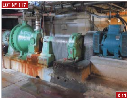
▶ Raffineur CLAFIN EMERSON, type 101, actuator à commande pneumatique 15-28 équipé de 3 vannes pneumatiques ▶ CLAFIN EMERSON refiner, type 101, actuator with pneumatic control 15-28 with 3 pneumatic valves.
