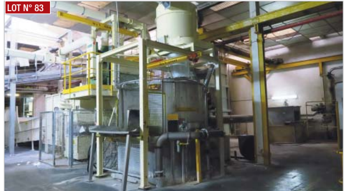
▶ Mélangeur découpeur TORNADO 2, filtre pilote et ensemble d'aspiration sur plateforme ▶ TORNADO 2 cutting mixer, pilot filter and suction assembly on platform
