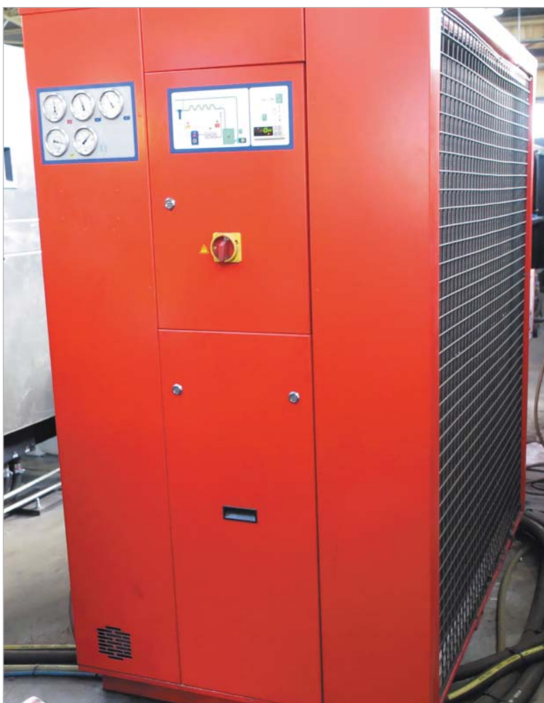
► Refroidisseur DONALDSON Modèle : ultracool 0400 SP N° de série : 48762 Année 2009 Réfrigérant R-407C 10kg PSH 28 bar PSL 16 bar TSH 120°C TSL -10°C 400V/3 50Hz 16,4 kW
